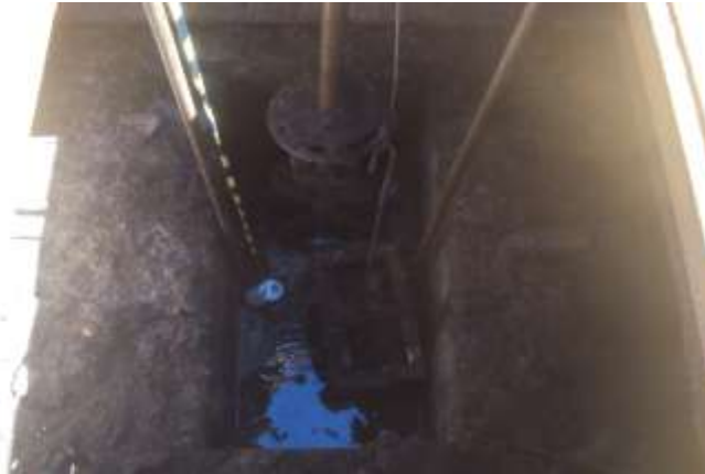
Figura 2. Coleta de efluente bruto na estação elevatória.
